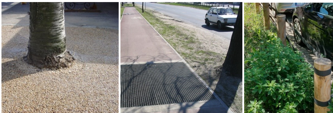
Ryc. 2. Przykłady rozwiązań ograniczających kolizję z zielenią: 1. Nawierzchnia przepuszczalna dla wody w obrębie SOD / 2. krata na ciągu komunikacyjnym umożliwiająca spływ wody opadowej do strefy korzeniowej (Źródło: www.rowery.org.pl ) / 3. ogranicznik wjazdu.
