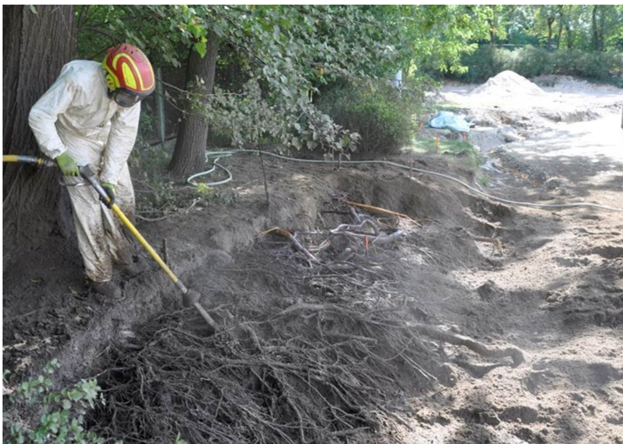
Ryc. 3. Prace odkrywkowe w strefie SOD wykonywane za pomoc sprężonego powietrza. Fot. Maciej Motas.
