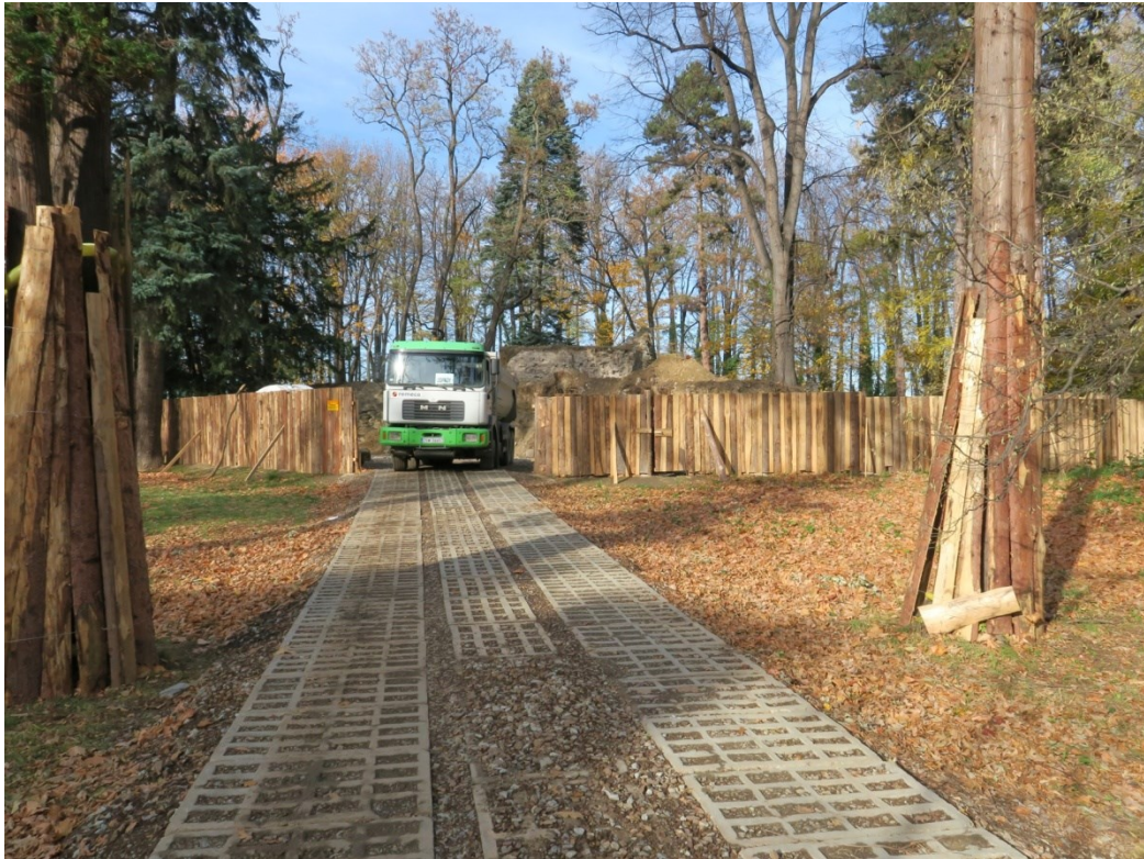
Ryc. 6. Zabezpieczenie korzeni w strefie ochrony drzewa - droga techniczna ułożona na geowłókninie i podsypce z kruszywa. Fot. Piotr Reda
