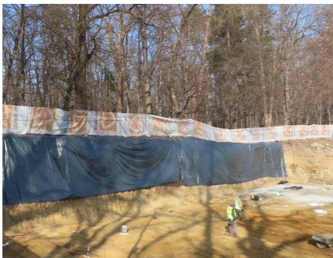
Ryc. 8. Zabezpieczenie strefy korzeniowej w dużym wykopie.
