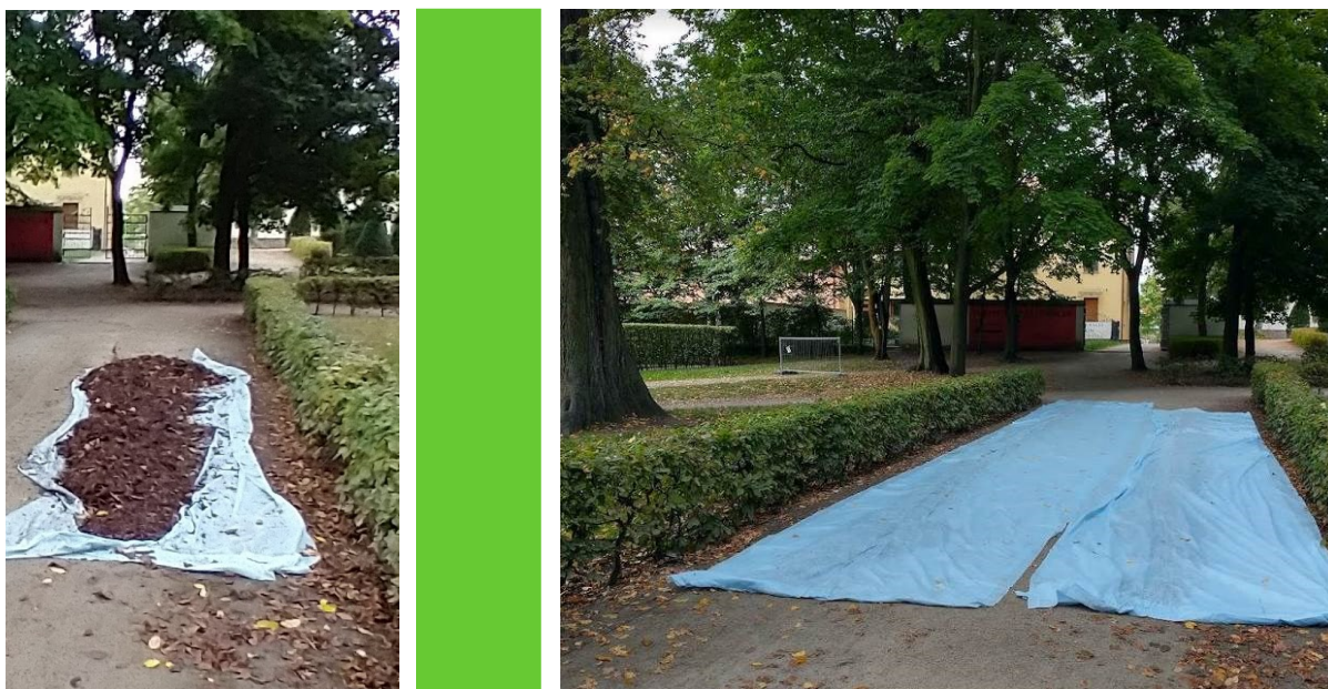
Ryc. 5. Zabezpieczenie korzeni w strefie ochrony drzewa - przykład ograniczenia nacisku na nawierzchnię w rejonie cennego drzewa. Strefę przejazdu, wyłożono 10-15cm warstwą zrębków, które ułożono w włókninie aby ograniczyć ich rozwożenie oraz ułatwić sprzątanie terenu. Fot. Łukasz Dworniczak
