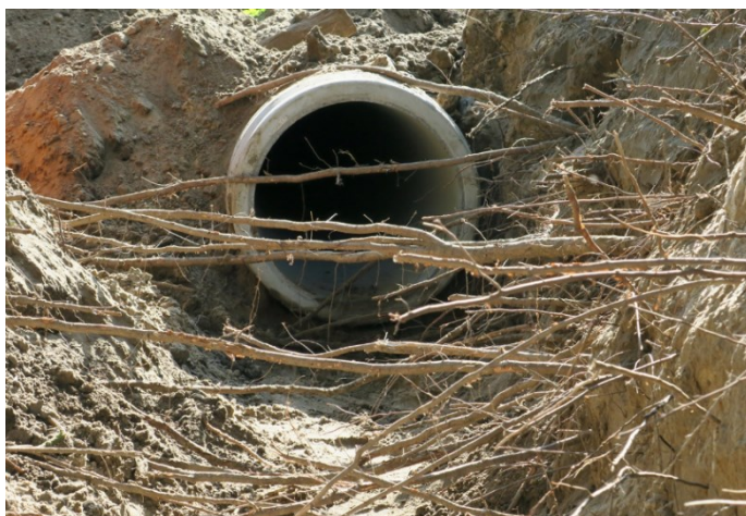
Ryc. 9. Zabezpieczenie korzeni w wykopie krótkotrwałym – wykop wykonano lekkimi narzędziami aby nie uszkodzić korzeni.
