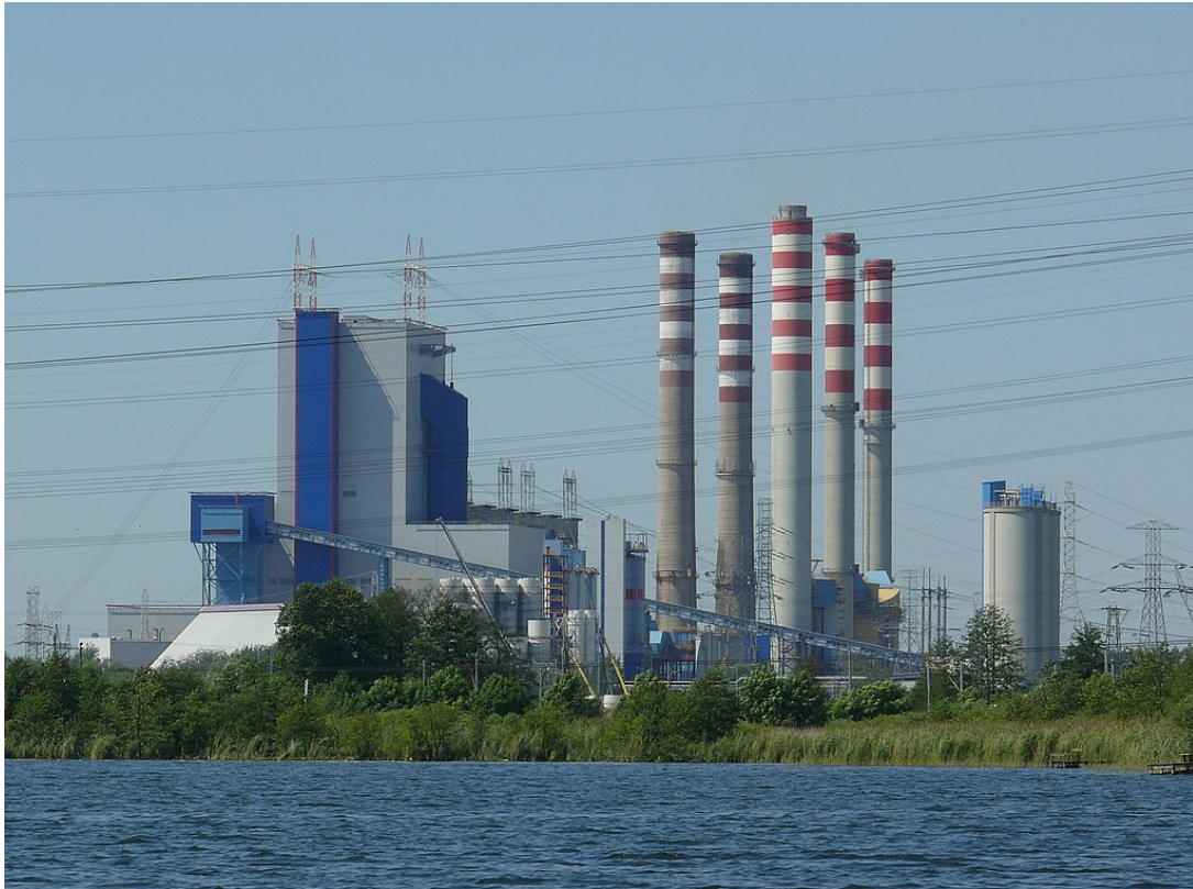
Zdjęcie 2. Elektrownia Pątnów. Źródło: https://commons.wikimedia.org/wiki/File:Elektrownia_P%C4%85tn%C3%B3w.jpg [dostęp: 12.02.2022 r.]
