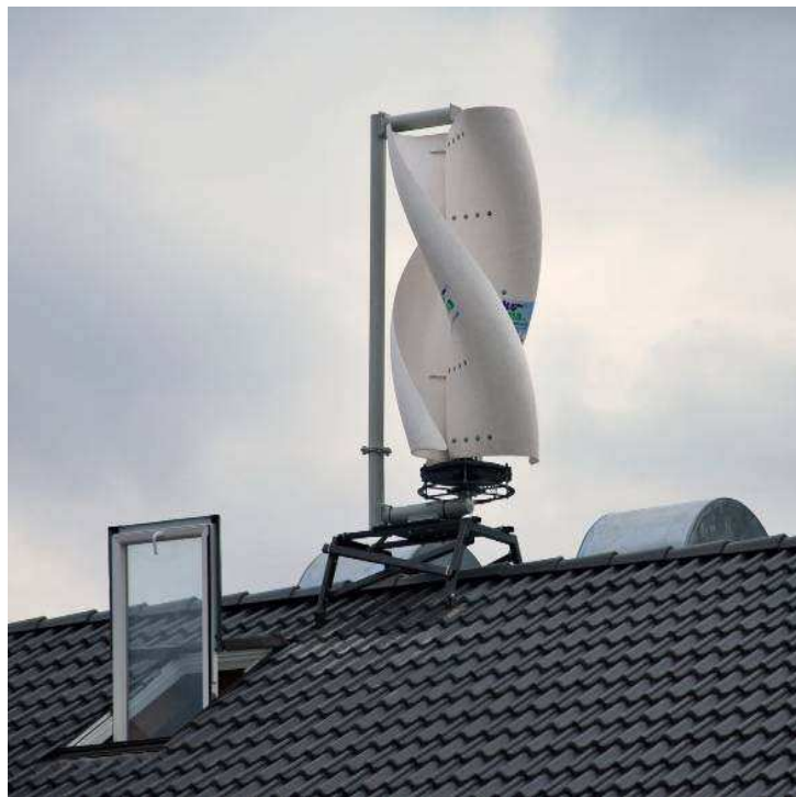
Fotografia 2. Przykład małej turbiny pionowej (Eko-Diuna). Źródło: materiały producenta
